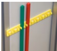
Elementy blokady bezpiecznika - uchwyt na belkę blokujacą
